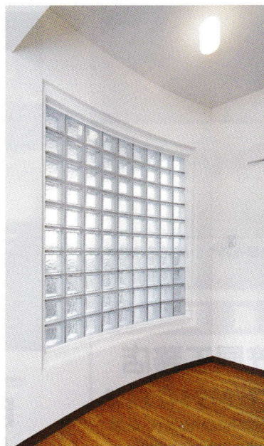
アールをつけた1階の階段室はガラスブロックで明るいスペースに。ガラスブロックを美しい曲面に施工する職人仕事も見事なばかり
